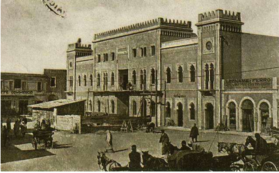
شكل رقم 7 مبنى البلدية والميدان أثناء بناءه حوالي عام 1914 (CHI - UPDATE - the Old City of Benghazi, 2020)
